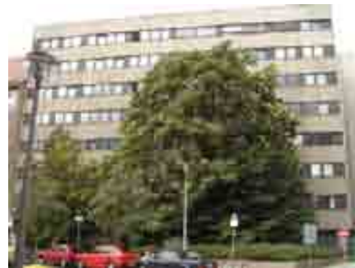
Prior to restoration | Vor der Sanierung | Avant rénovation
