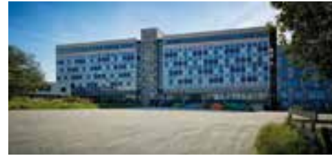
Before | Vorher | Avant
