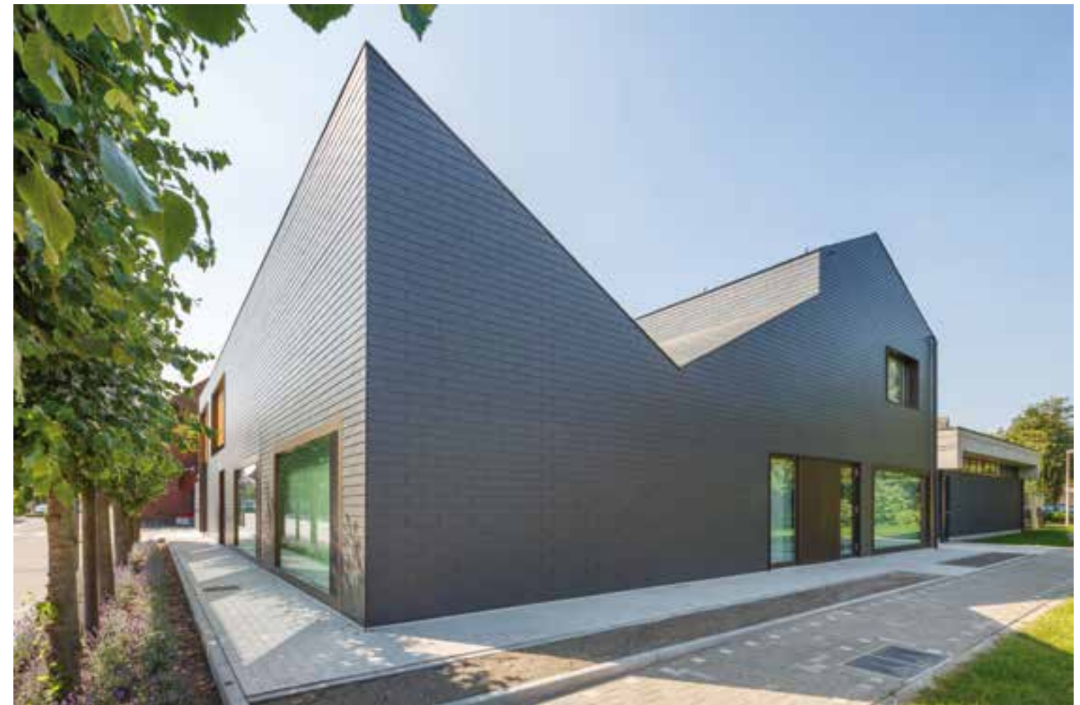
Southeast corner | Südostecke | Angle sud-est
