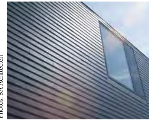
Photos: 8A Architecten
