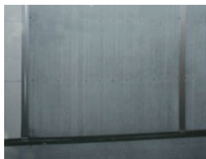
Vindspærren forseglet med tape
